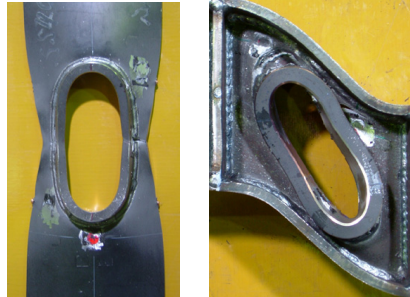
写真1 T40-10-22 終局状況 写真2 S40-15-22 終局状況
